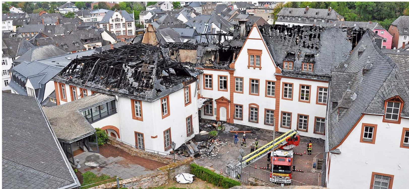
Diese Aufnahme verdeutlicht das ganze Ausmaß des Schadens nach dem Brand in der Saarburger Verwaltung.
